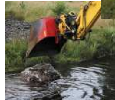
Med skopan placeras stenblocken i Pinnåns fåra
